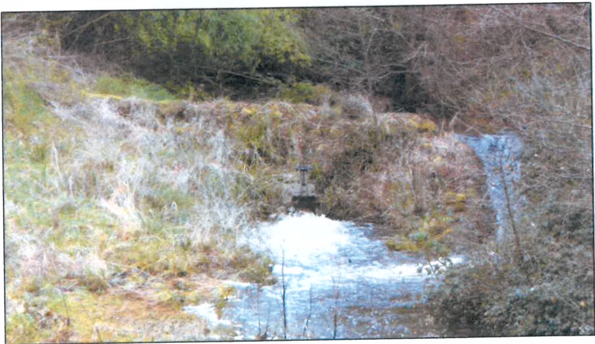
Figure 15 : Retenue d'eau vue de face
