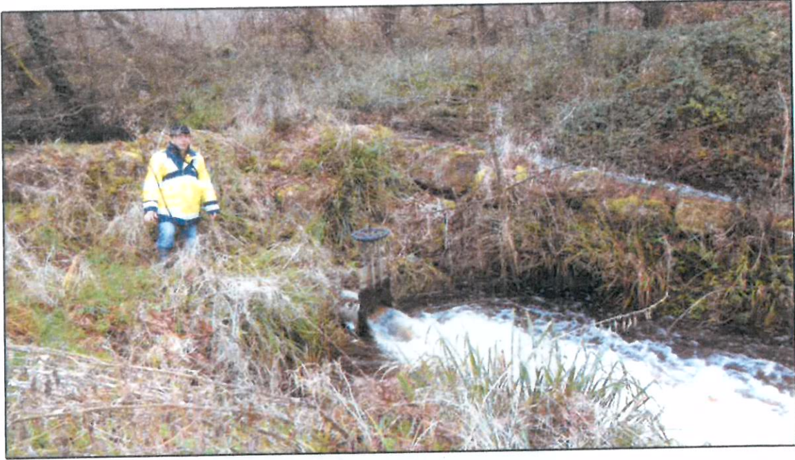
Figure 14 : Vue sur l'échelle à poissons et vanne
