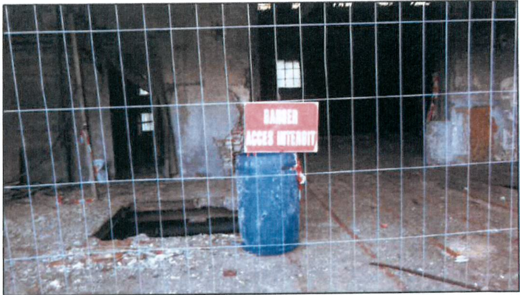
Figure 5 : Barriere et panneau de signalisation
